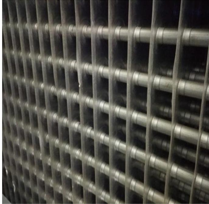
Escarcha en el evaporador y entrada de alimentación del túnel inteligente después de un mes de funcionamiento continuo :
