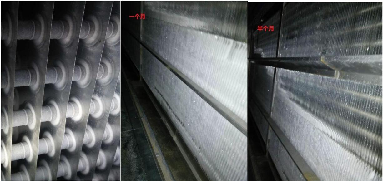
Los túneles inteligentes se pueden apagar y descongelar después de 1 mes de operación continua
